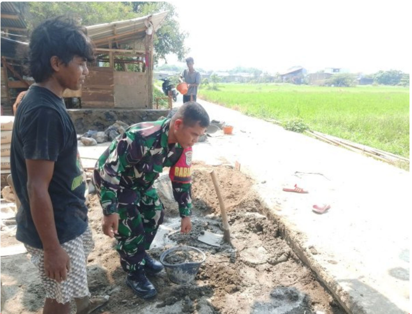
foto babinsa melaksanakan perbaikan jalan
